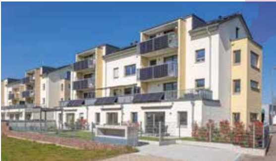
Wohnen und Kita „Am Schönberg“, Freiburg, St. Georgen Neubau von genossenschaftlichen Wohnungen, Eigentumswohnungen, einer Gewerbeeinheit und einer Kinderbetreuungseinrichtung
